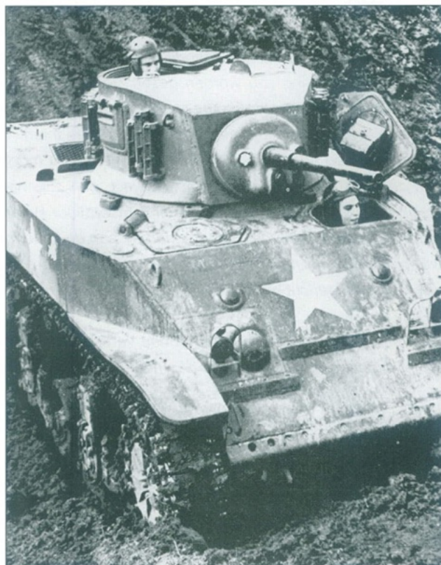
Deze foto van een Lichte Tank M5 tijdens trainingen in Engeland toont duidelijk de oude M3A1 toren op de nieuw ontworpen romp. (26 maart 1943, US Army)
